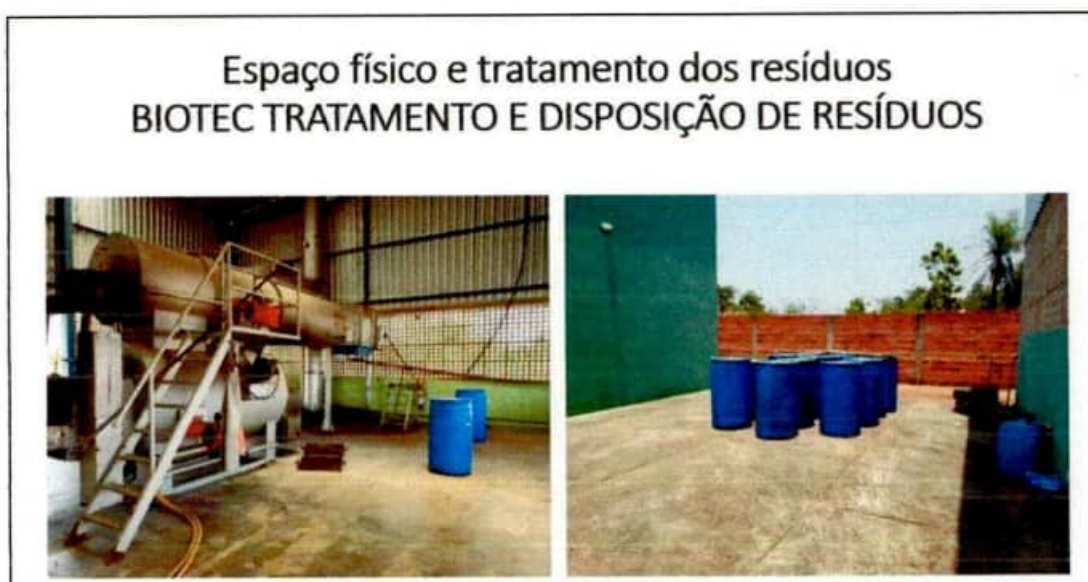
Foto 06 – Espaço físico - Biotec Tratamento e Disposição de Resíduos Perigosos
