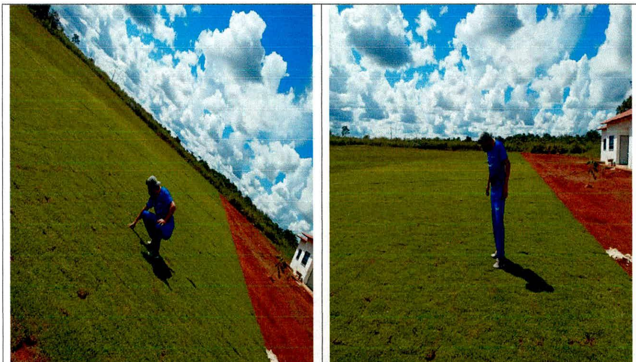
FIGURA 5/6 - OBSERVAÇÃO DA CONCLUSÃO DA PRESTAÇÃO DE SERVIÇO DA IMPLANTAÇÃO DE GRAMA.
